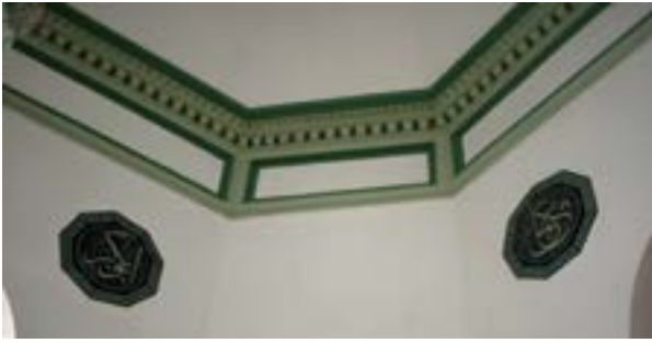
Fotoğraf 14. Saçak kornişleri ve alçı süslemelerden görünüm
