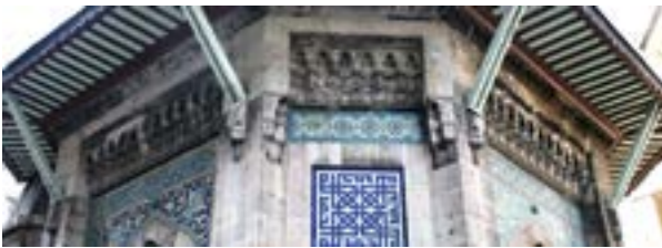
Fotoğraf 5 Saçakla duvarı ayıran dendanlı kuşak, payandalar ve mukarnalı süsleme.
