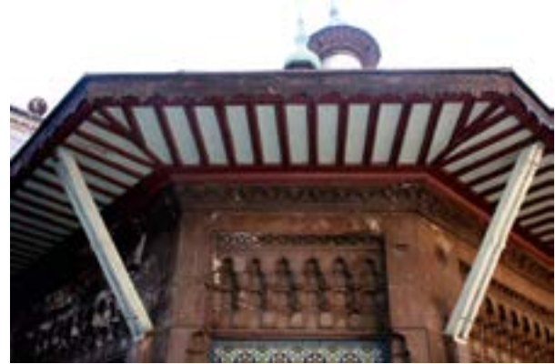
Fotoğraf 6. Saçakla duvarı ayıran dendanlı kuşak, payandalar ve mukarnalı süsleme.
