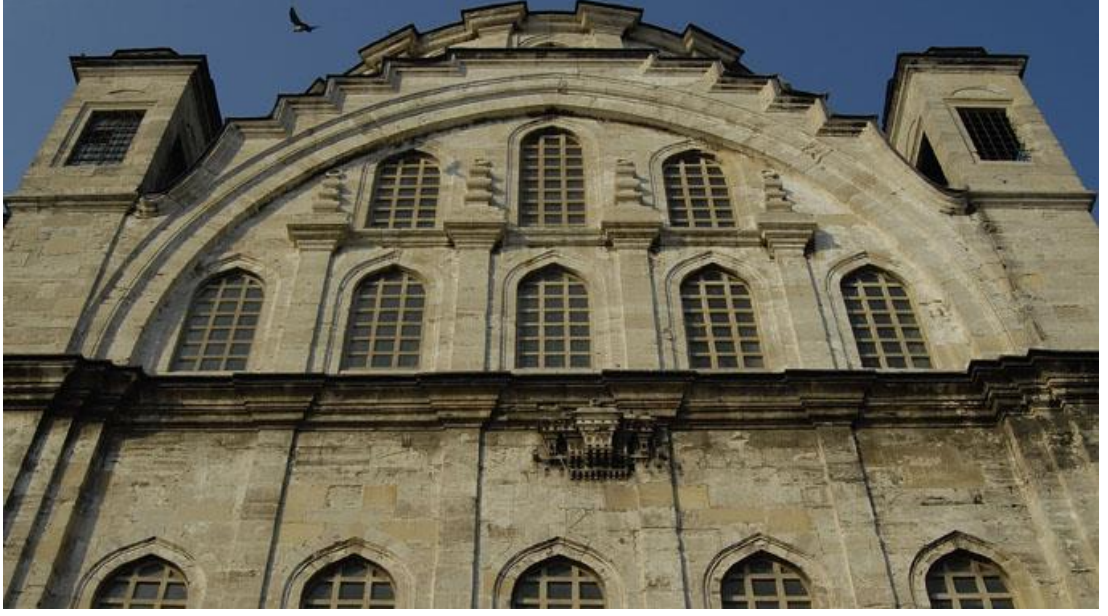
Resim 3 4: Ayazma Camii sivri kemerli pencereler (Url-4)
