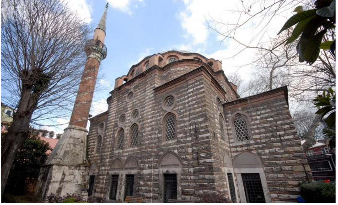
Resim 3 12: Zeynep Sultan Cami, dış cephe taş döşemesi, kubbe eteği ve minaresi (Url-4)
