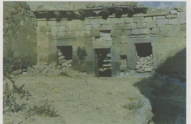
Resim 5: Aşhane (Mutfak)nin batı duvarından bir görünüş.
