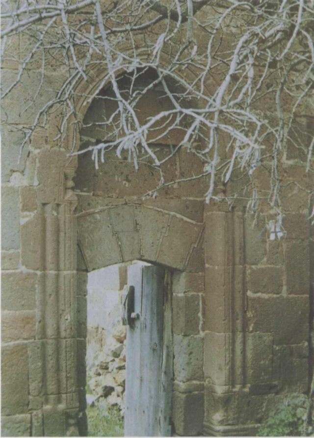
Resim 13: Mescidin doğu duvarında yer alan giriş kapısı.
