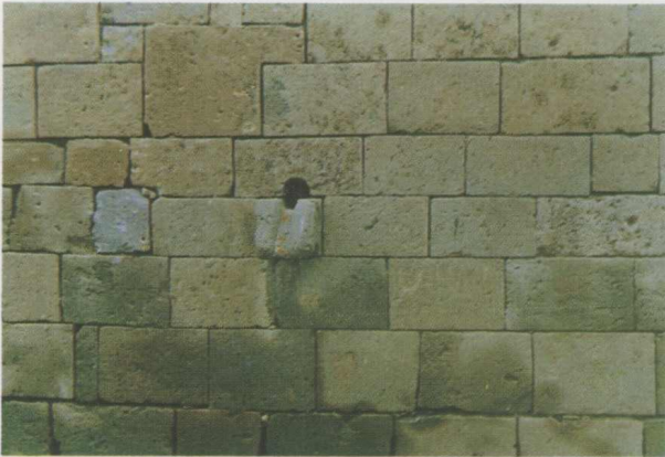
Resim 4: Güney duvarda yer alan çörtlenlerden biri.
