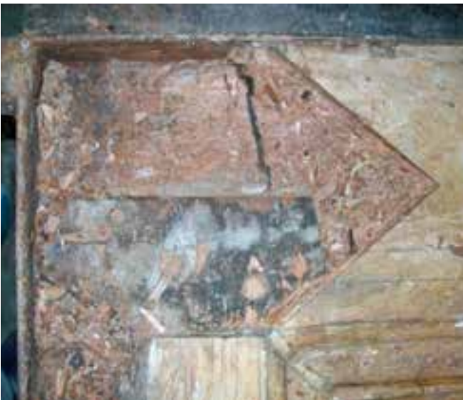
Fotoğraf 17-18. Hünkâr Kapısı ahşap parça değişimleri
