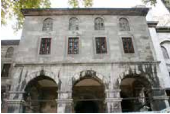
Fotoğraf 30-31. Hünkâr Kasrı Kuzeydoğu cephesi taş yüzeydeki kirlilikler
