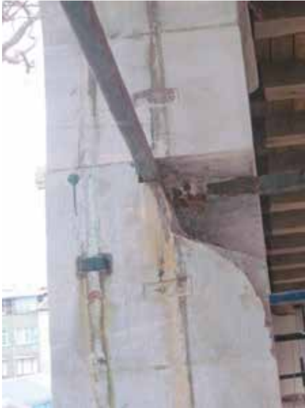
Fotoğraf 32-33. Hünkâr Kasrı cephesi taş hasarları ve taş değişimi
