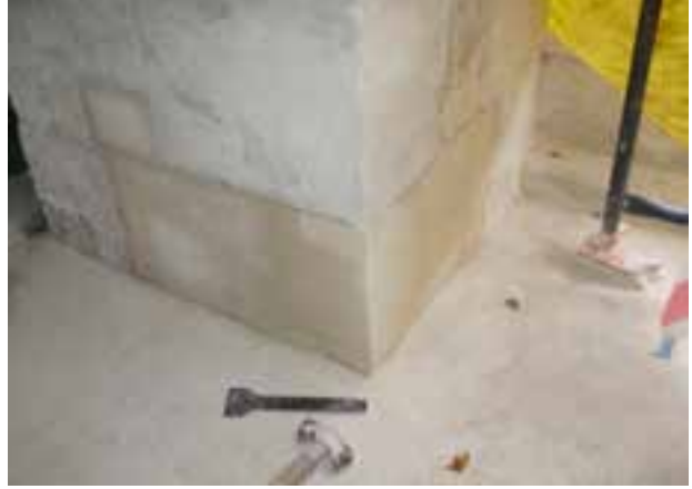
Fotoğraf 35-36. Hünkâr Kasrı'nın cephesinde taş değişimi
