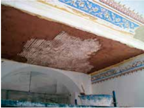
Fotoğraf 6-7. Hünkâr Kasrı iç mekân kalemîşi ve tavan içinde özgün horasan sıva yapımı
