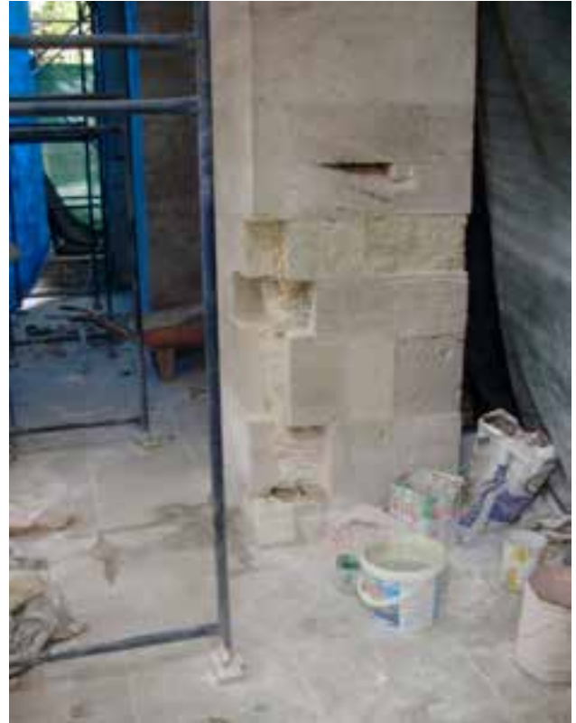
Fotoğraf 32-33. Hünkâr Kasrı cephesi taş hasarları ve taş değişimi
