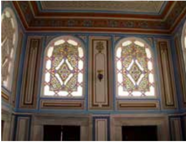
Fotoğraf 12. İç mekândaki onarım sonrası içlik ve kalemişi yüzeyler
