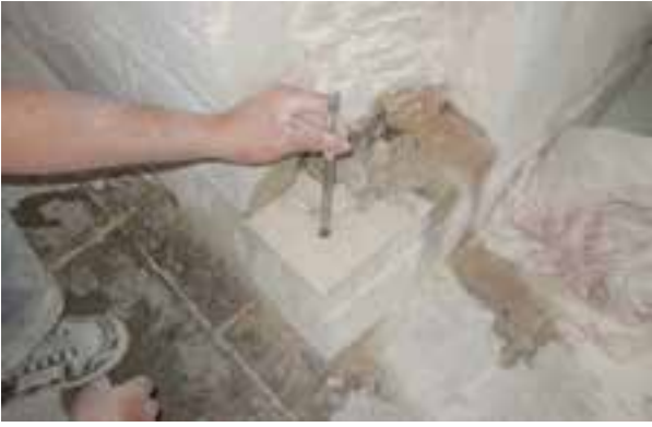
Fotoğraf 34. Hünkâr Kasrı'nın cephesinde taş değişimi
