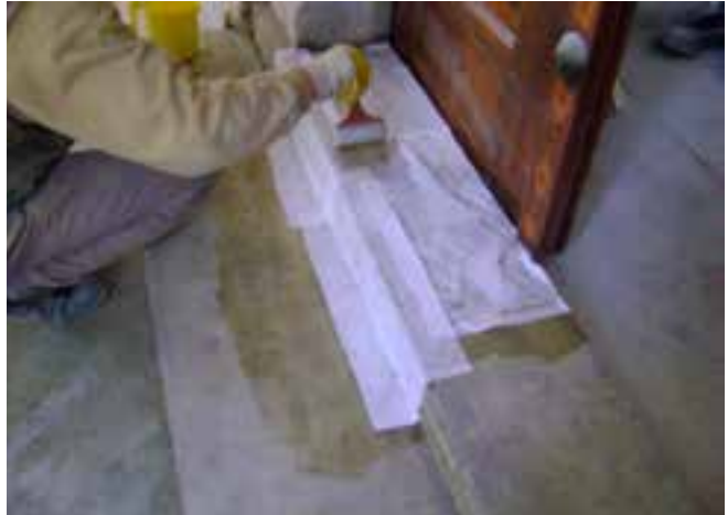
Fotoğraf 37-38. Hünkâr Kasrı rampasının merdiven basamaklarında AB57 uygulaması
