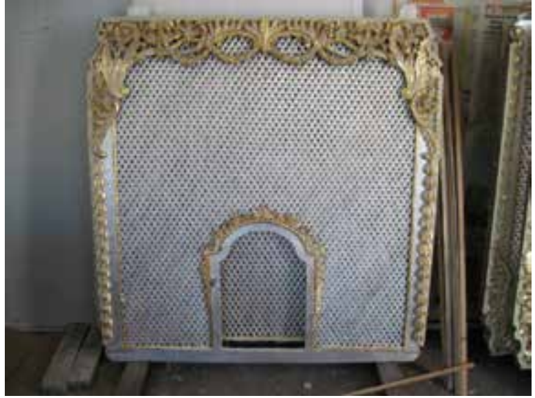
Fotoğraf 28-29. Kafeslere altın ve gümüş varak yapılması
