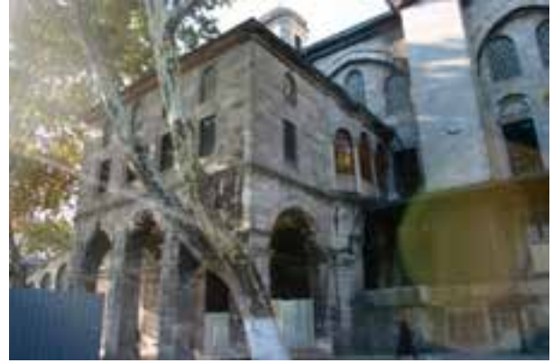
Fotoğraf 30-31. Hünkâr Kasrı Kuzeydoğu cephesi taş yüzeydeki kirlilikler
