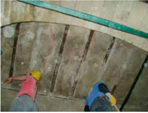
Fotoğraf 41-42. Hünkâr Kâsrı kuzeydoğu giriş kısmı tavan yüzeyindeki metal gergilerin temizliği
