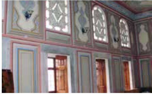
Fotoğraf 23. Hünkâr Kasrı iç mekân onarım sonrası genel görünüm
