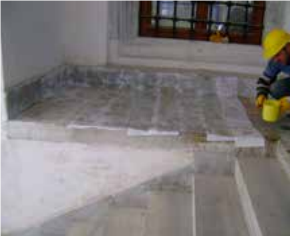
Fotoğraf 37-38. Hünkâr Kasrı rampasının merdiven basamaklarında AB57 uygulaması
