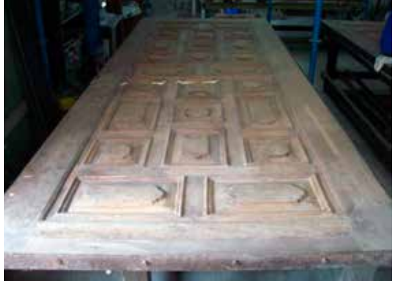
Fotoğraf 15-16. Hünkâr Kapısının ahşap kanatının üzerinden boya sökümü
