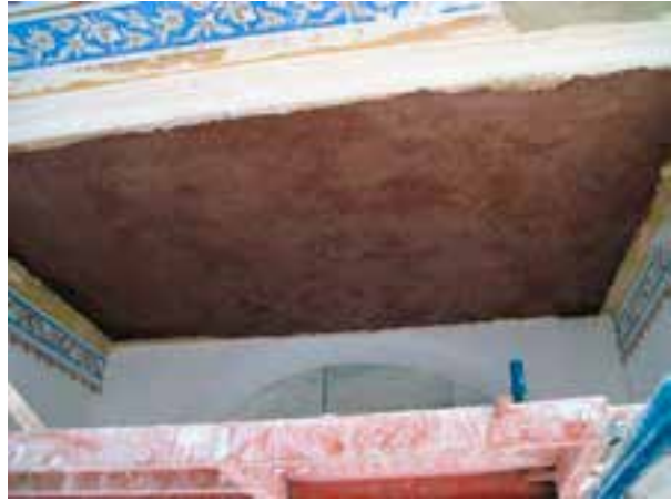
Fotoğraf 6-7. Hünkâr Kasrı iç mekân kalemîşi ve tavan içinde özgün horasan sıva yapımı
