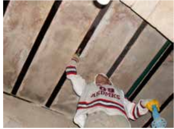
Fotoğraf 41-42. Hünkâr Kâsrı kuzeydoğu giriş kısmı tavan yüzeyindeki metal gergilerin temizliği
