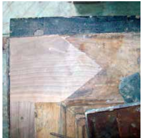
Fotoğraf 17-18. Hünkâr Kapısı ahşap parça değişimleri
