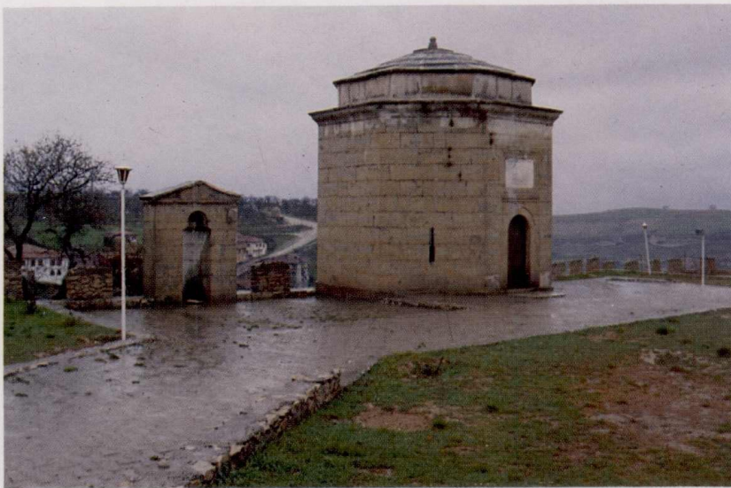
Resim 31: Zonguldak, Safranbolu, Hıdırlık Tepesi'nde Hasan Paşa Türbesi yanındaki açık mihrab.
