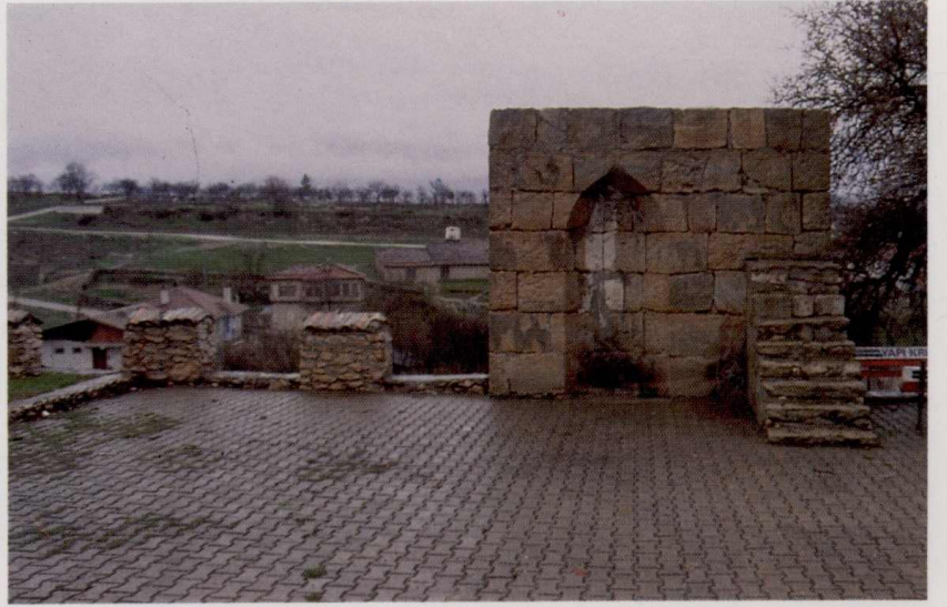
Resim 30: Zonguldak, Safranbolu Namazgahı, ön cephe.
