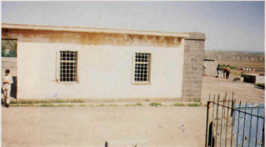
Resim 28: Diyarbakır Namazgahı, sağ yan cephe.
