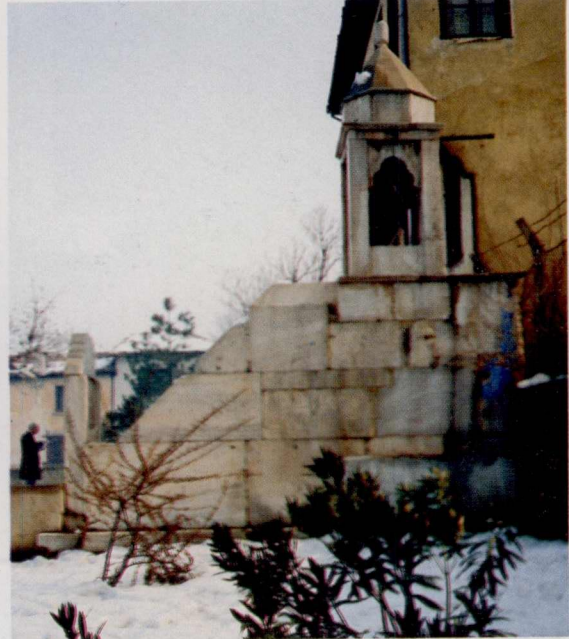
Resim 14: Bursa Umurbey Namazgahı, minber, sağ yan cephe.
