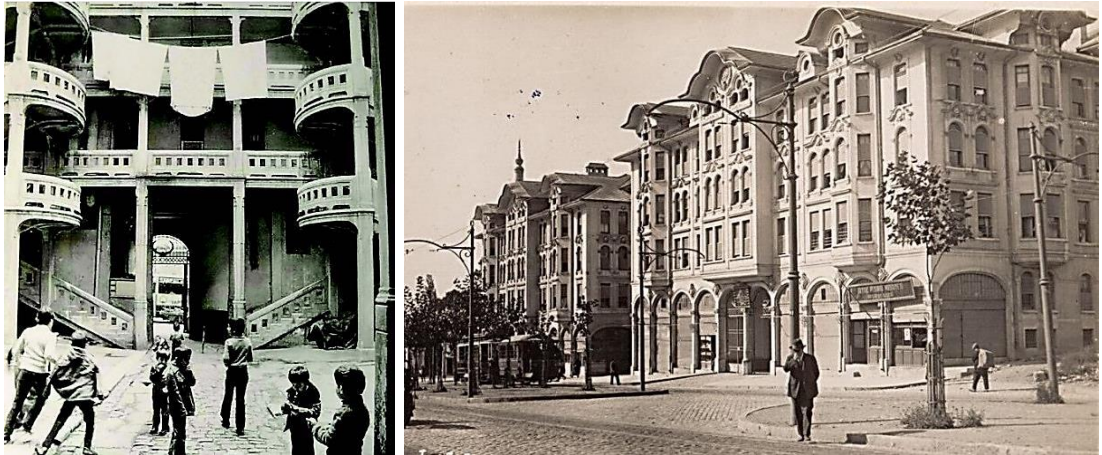
Şekil 4.3: İstanbul Teyyare apartmanı iç avlu ve dış cephe görselleri (Url-48).
