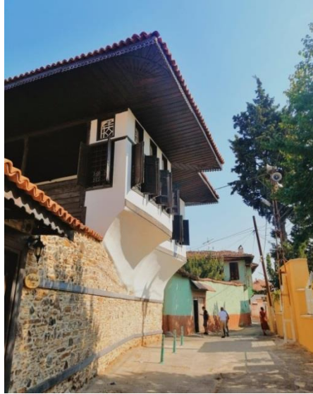
Şekil 1.21: Geleneksel Türk Evi zemin kat duvar yapısı ve üst kat çıkma örneğini gösteren yapı (Url-43).
