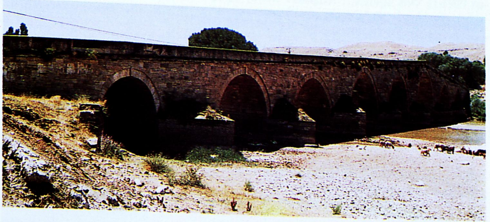
Res. 7: Şahruh Köprüsü'nün kuzeydoğu cephesinden görünümü.
