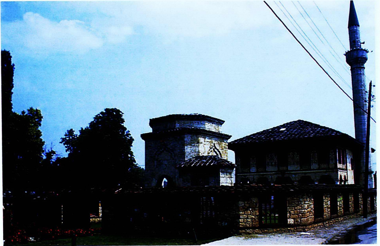
Res. 2: Alaca Camii kuzey cephesi ile türbe ve çeşme yapıları.
