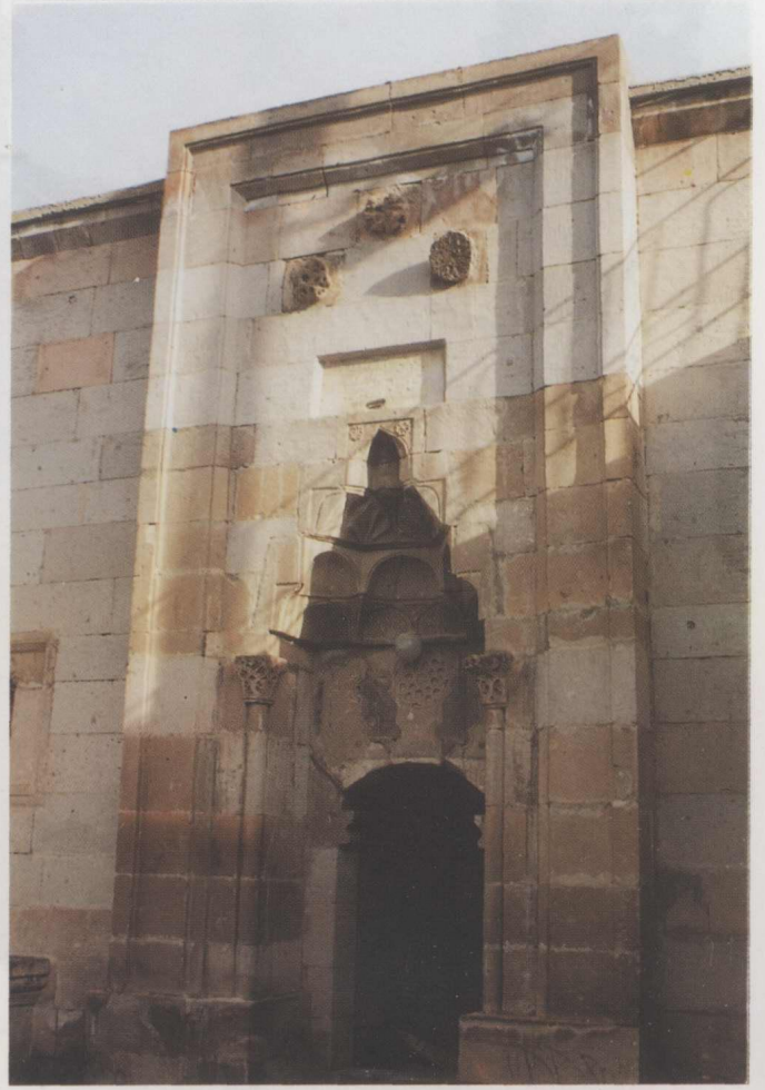
Res. 4: Alaüddevle Camii taçkapısının genel görünüşü
