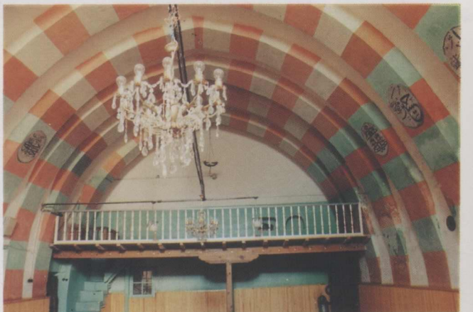
Res. 18: Yazlık mescitin güney cephesinin içten genel görünüşü
