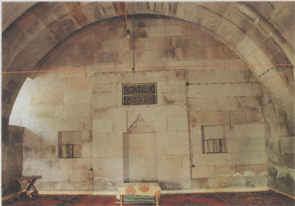
Res. 5: Alaüddevle Camii hariminin güney cephesinin genel görünüşü
