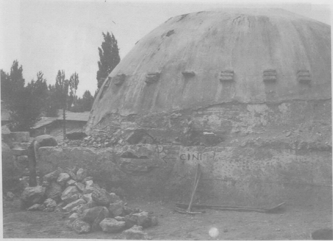
Res. 12: Mescit kubbe eteğinde 2 sıralı tuğla bingiler, çentiklenmiş kasnak ve çini kalıntısı.
