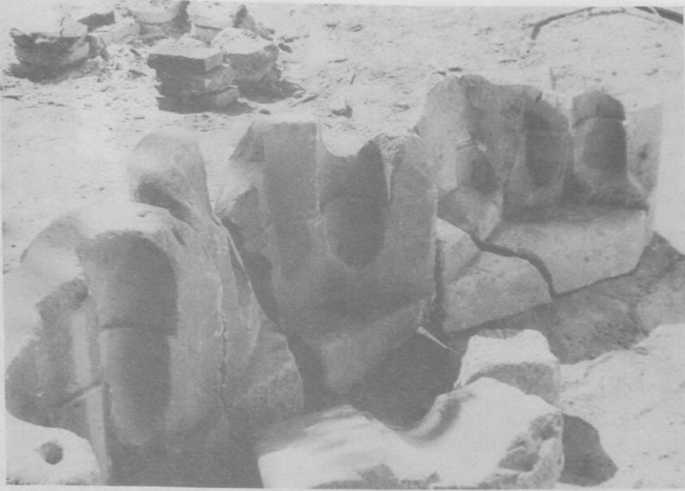
Res. 4: Avlu temizliğinde bulunan havuz korkuluğu ve su arki.
