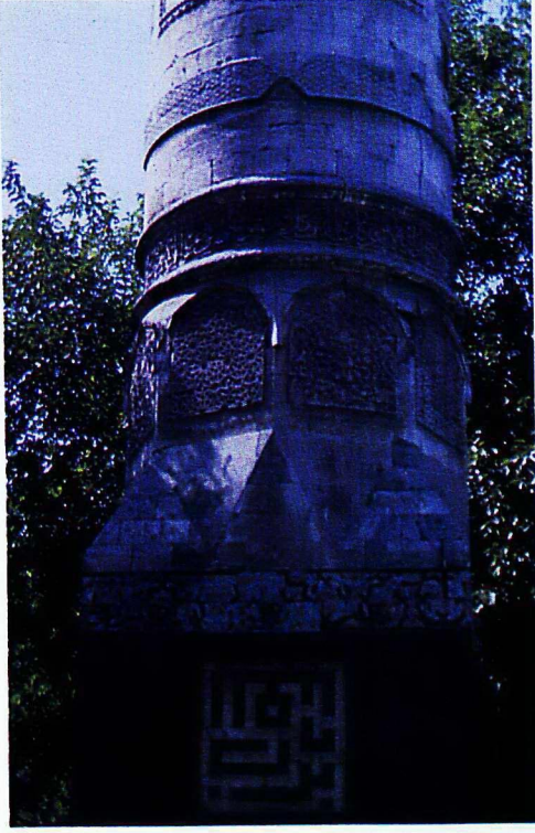
Res. 15: Diyarbakir Merkez Safa Camii minaresi detay (Fotoğraf A. Kılıcı 1991).
