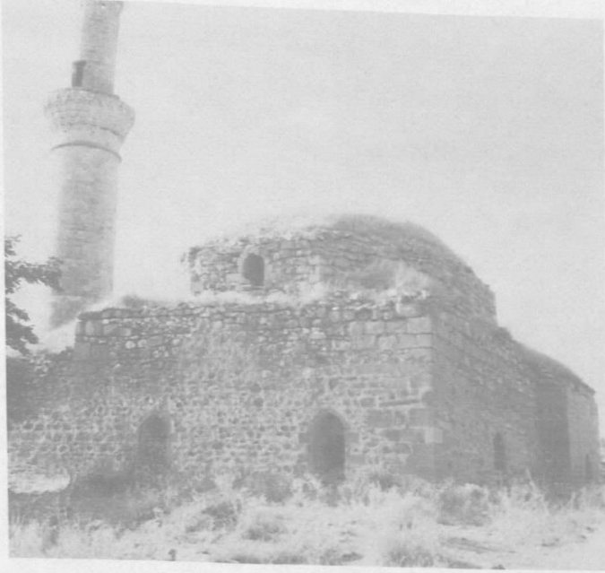
Res.17: Pertek, Çelebi Ali Camii, taşınmadan önceki durumu (VGM Arşivi).
