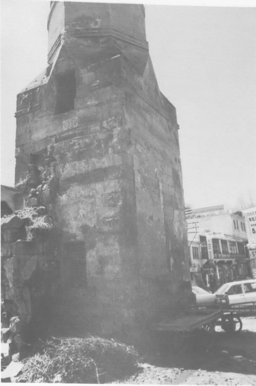
Res. 1: Merkez Meydan Camii minare kaide genel görünüşü.
