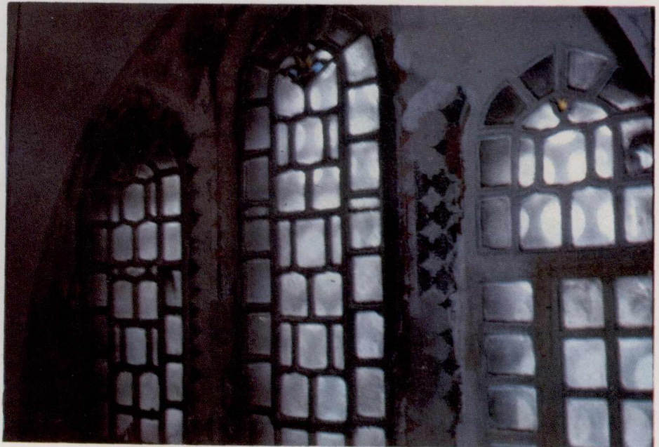
pencere çerçevesinde yapılan raspalardan çıkan bulgular
