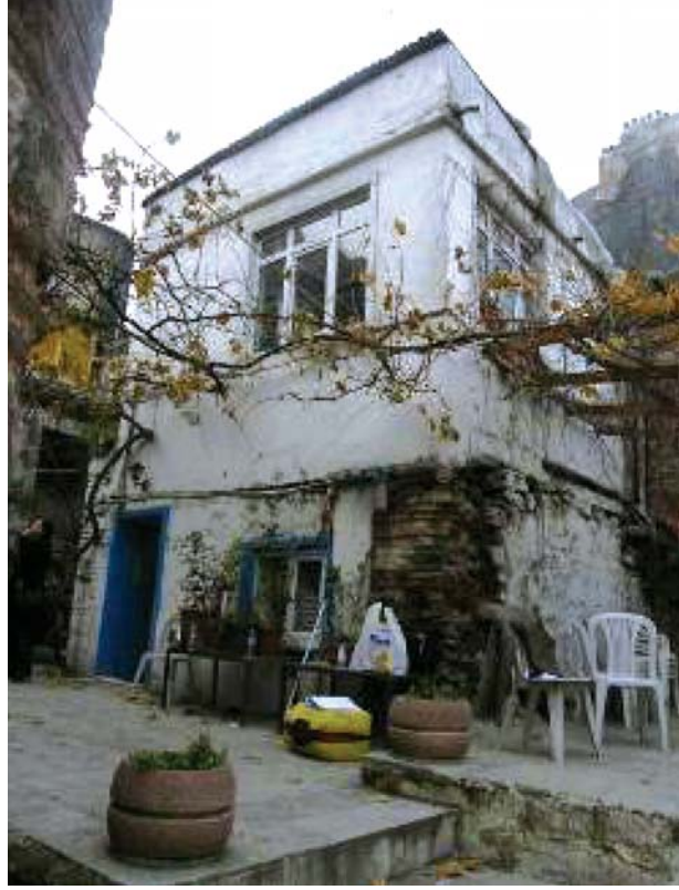
Resim 18: Avluda yer alan betonarme yapı
