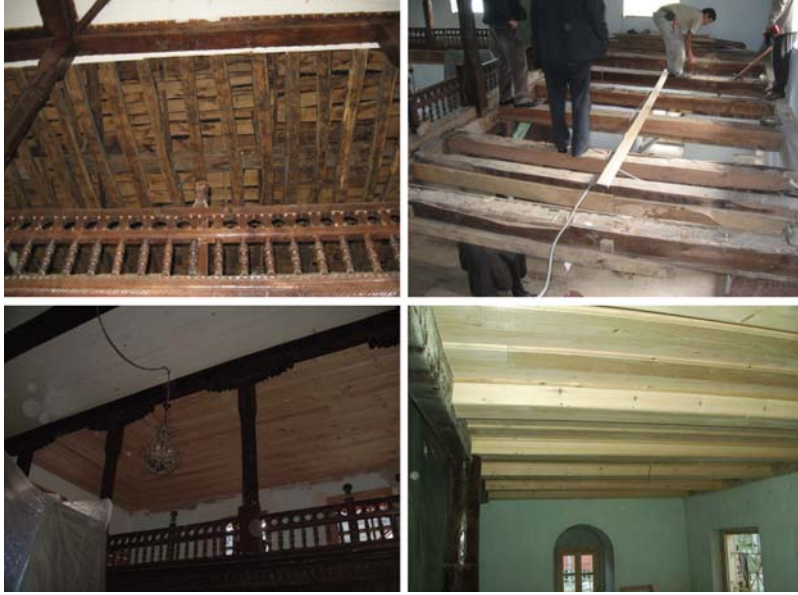
Resim 16: Mahfil tavan ve döşemesinin onarım-yenilenmesi
