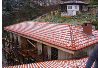
Resim 12: Çatının onarılacak hali, kiremit ile kaplanması
