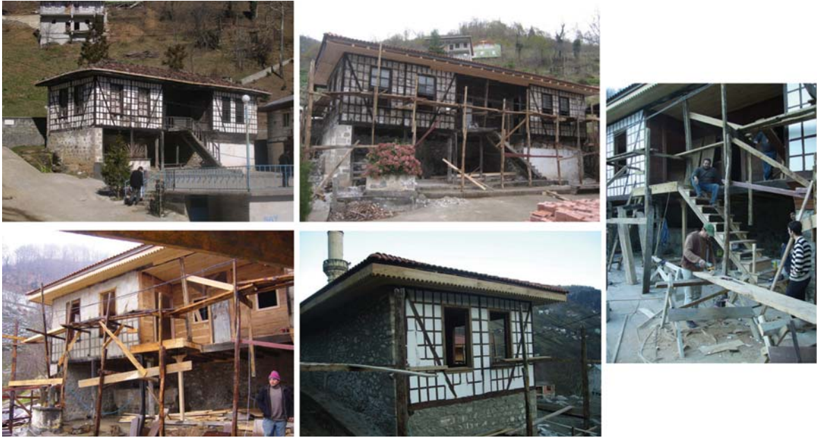
Resim 15: Medrese binasının duvarlarının onarımı
