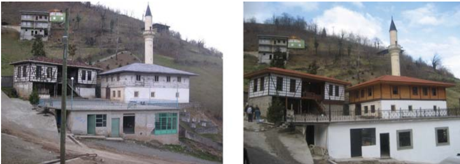
Resim 21: Trabzon-Dernekpazarı Tařçılar ky camii onarım ncesi ve sonrası
