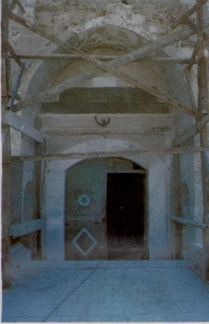
Resim 8-Onarım Aşamasında Kuzey Kapısı
