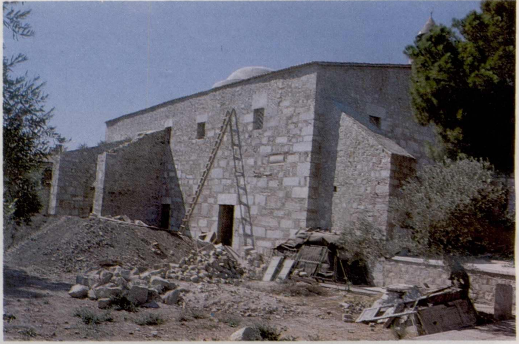
Resim-4 Onarımda Batı cephe
