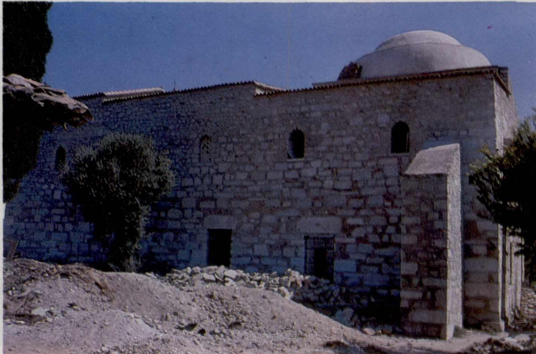
Resim-7 Onarımda Doğu Cephe
