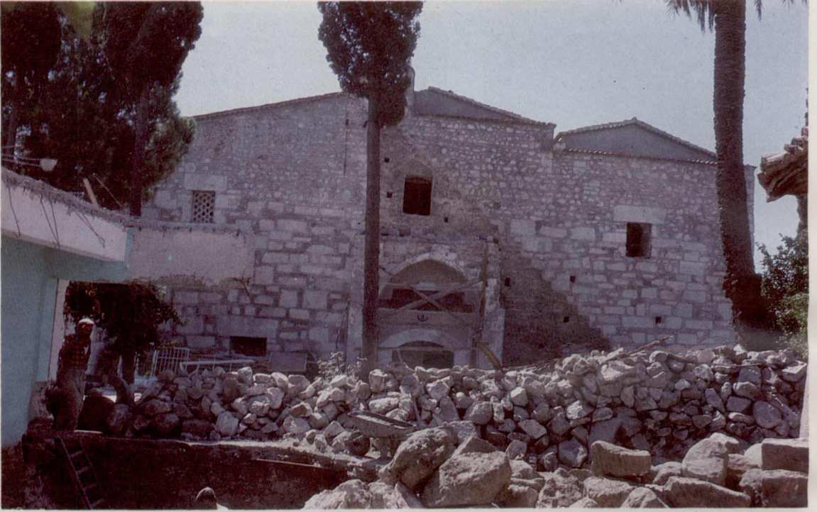
Resim - 21 Portal Açık Merdiven Sökülmüş Hâli
