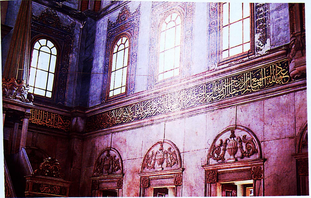
Resim 2- İstanbul'da Nusretiye Câmii'nde Mustafa Râkım'a âid, taşa oyulduktan sonra varak altınla kaplanmış ve zemîni de siyaha boyanmış şâheser celf sülûs kuşağı.
