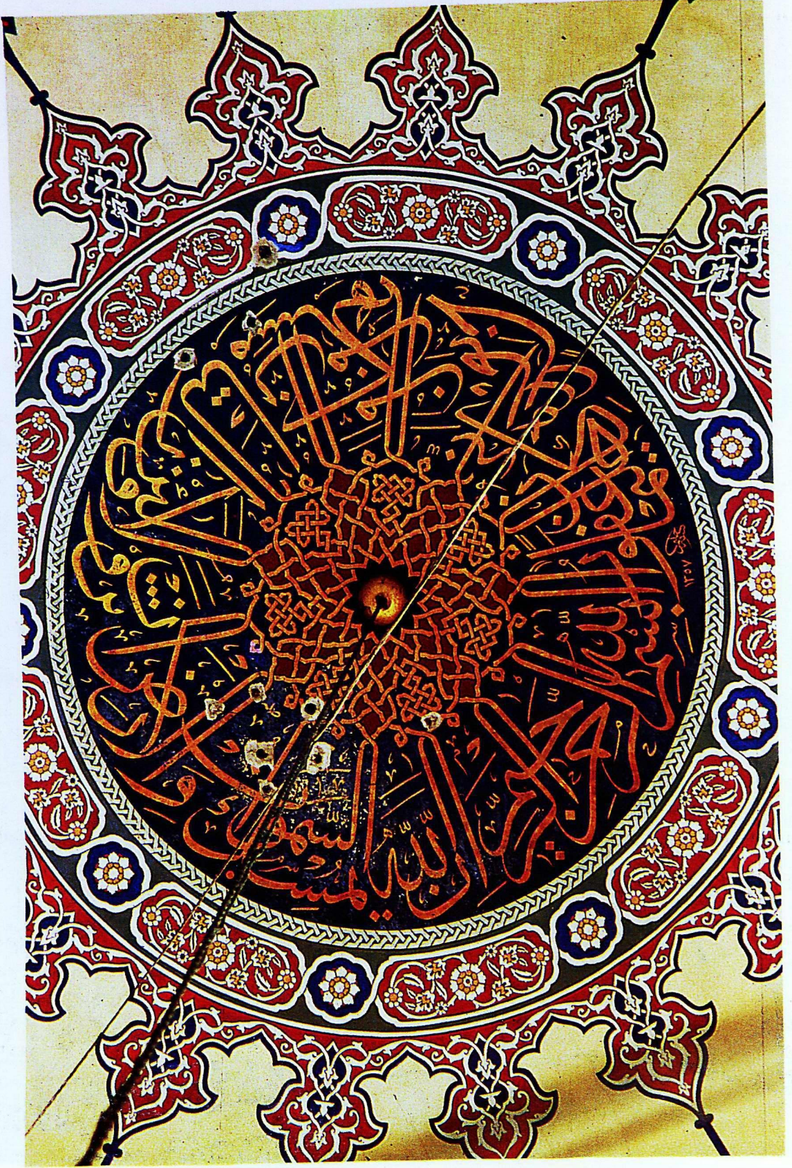
Resim 6- İstanbul- Kadırga'daki Şehid Mehmet Paşa Câmii'nin kubbe yazısı. Halim Özyazıcı'nın bu muhteşem celif sülüs hattı rutubet alarak dökülmeye başlamıştır.
