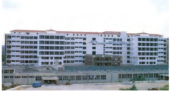
Resim 6. Yeni hastane binasının inşaatı
