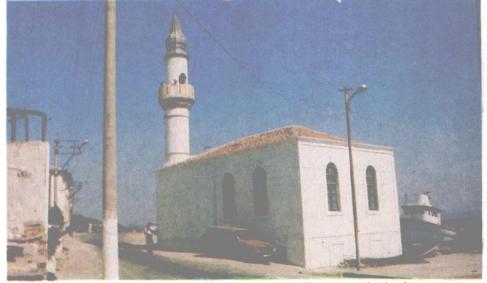
Resim 4: Çanakkale Eceabat, Kilitbahir Bucağında bulunan Tabip Hasan Paşa Camii.
