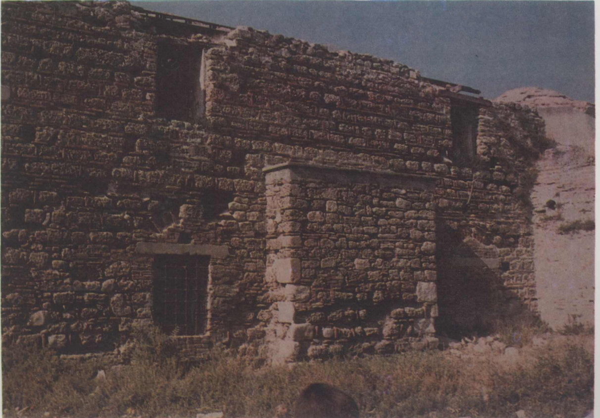
Resim 2: Gelibolu-Saruca Paşa Hamamı erkekler kısmı soyunmalıđı güney cephesi.
