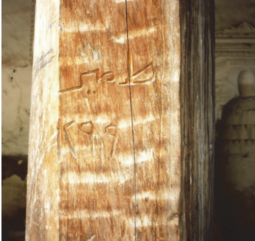
Fot. 19. Değirmenyolu/Parlasan Köyü Hacı Ahmet Camii harimdeki ayak üzerindeki tamir kitabesi.
