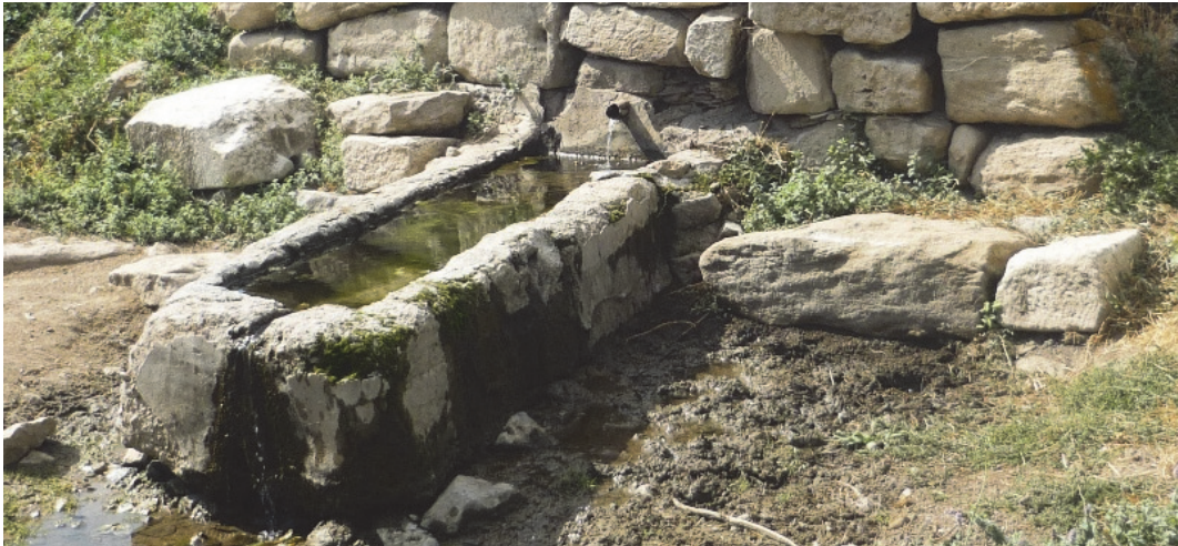
Fot. 29: Değirmenyolu/Parlasan Köyü Hacı Ahmet Camii'nin batı cephesi tarafında bulunan çeşme.
