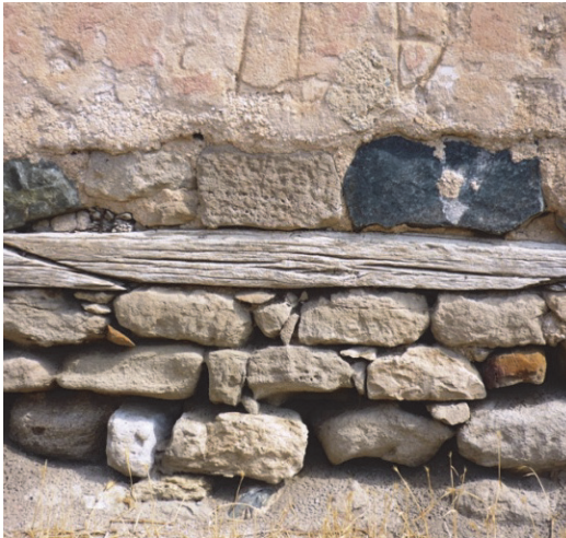
Fot.9. Değirmenyolu/Parlasan Köyü Hacı Ahmet Camii duvar örgüsü taş malzeme ve hatıl.
