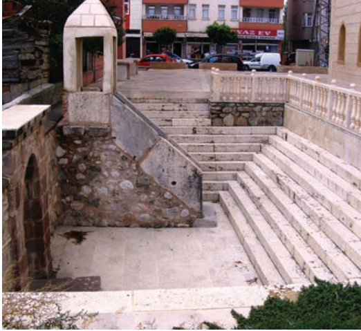
Resim 2 Vezirköprü Köprülü Mehmed Paşa Namazgâhı Doğudan Genel Görünüşü. (2008 Restorasyon Sonrası).
