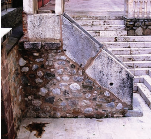
Resim 4 Vezirköprü Köprülü Mehmed Paşa Namazgâhı Minberi Doğu Yüzü. (2008 Restorasyon Sonrası).
