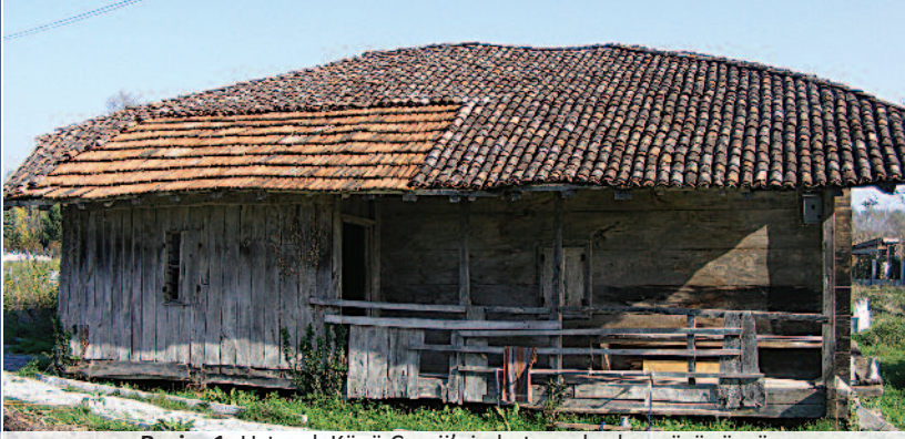
Resim 1: Ustacalı Köyü Camii'nin batı cepheden görünümü
